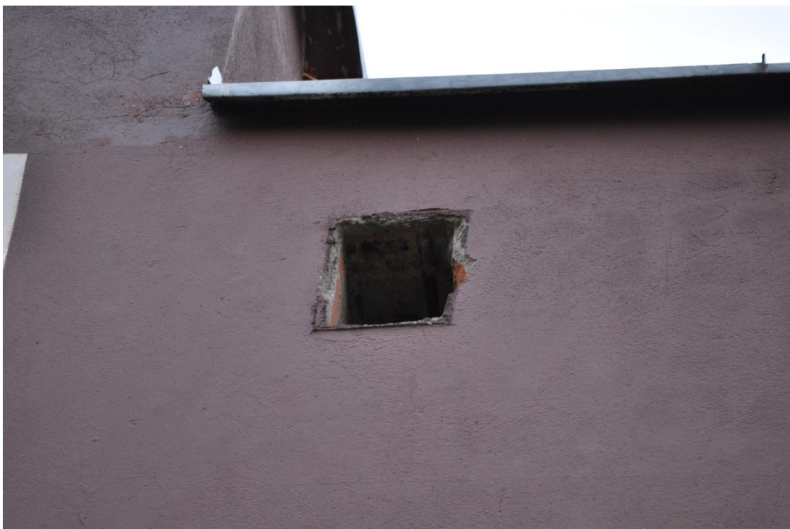
Fot. 5. Potencjalne miejsce gniazdowania ptaków, niezabezpieczony otwór wentylacyjny
